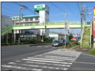
国道等の幹線道路に設置された歩道橋
