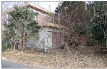
管理されていない空き家
